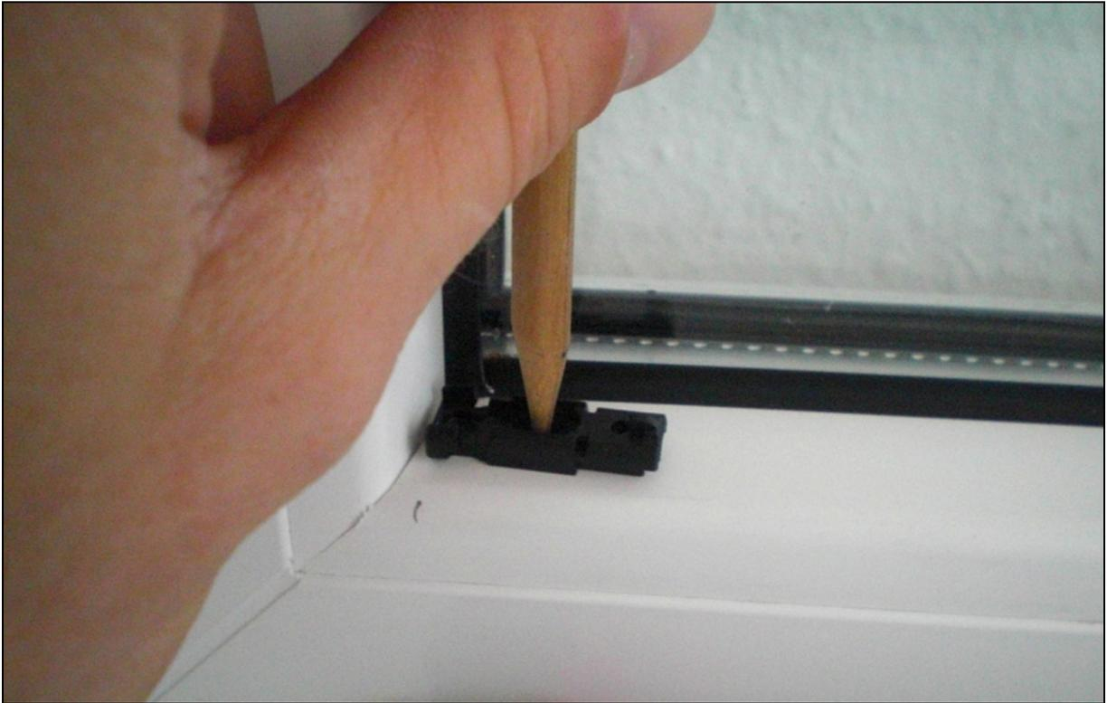
6. Halteplättchen auflegen und Markierung für die Bohrung setzen
